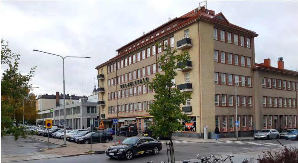
Näkymä Pormestarinkadulle; vasemmalla Kassatalo, seuraavana kaksikerroksinen Osuuspankin entinen pankkitalo, keskellä Viljelytalo ja takana oikealla Kulmatalo. Korttelin kulmarakennukset ovat viisikerroksisia ja muodostavat hallittua kaupunkikuvaa. (Lappeenrannan kaupunkisuunnittelu)
